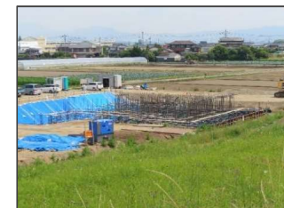
陣屋川ポンプ増設工事
