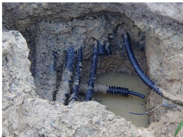
平成27年8月18日 選手宿舍裏水道管漏水(選手宿舍裏水道管より漏水(写真左)発生。その漏水が使用していないPF管(写真右)に流入し、漏水箇所より離れたバンク内に漏出したためバンク舗装を破壊した。
