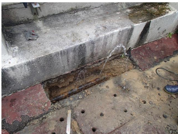
平成27年8月18日 選手宿舍裏水道管漏水(選手宿舍裏水道管より漏水(写真左)発生。その漏水が使用していないPF管(写真右)に流入し、漏水箇所より離れたバンク内に漏出したためバンク舗装を破壊した。
