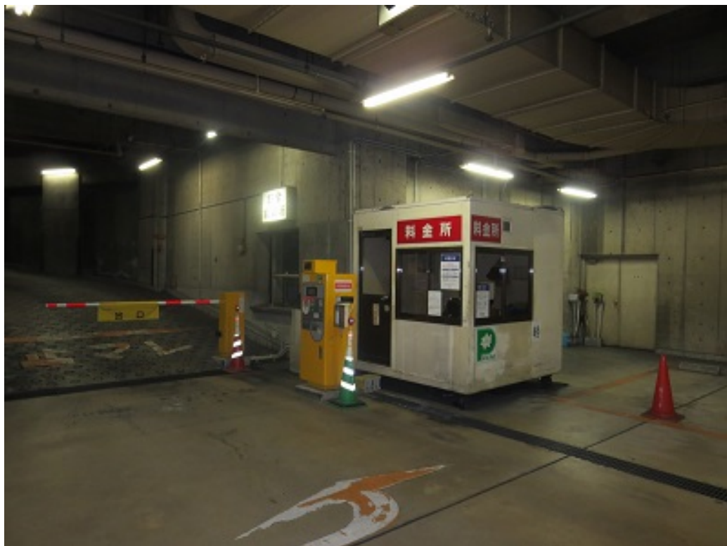
駐車場出口ゲート付近を撮影
