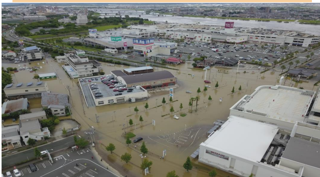
東合川地区浸水状況(ゆめタウン近郊)
