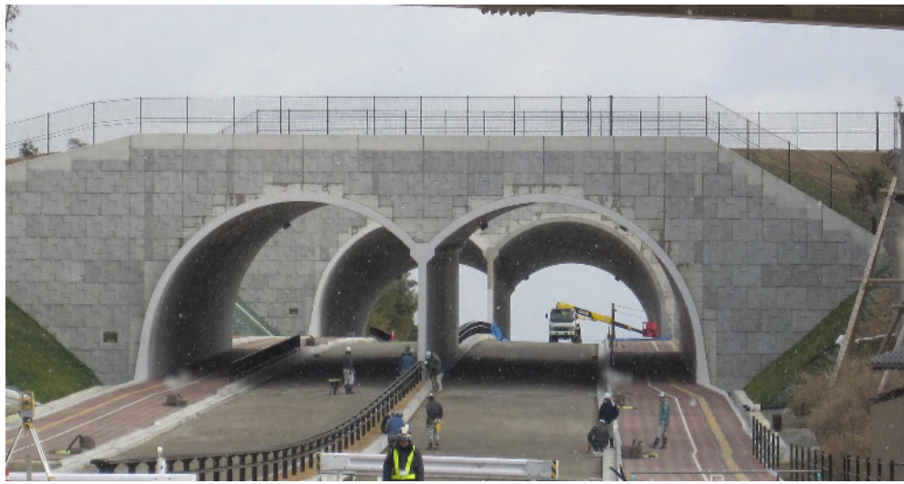
丘陵部その2工事（奥はその1工事。平成26年1月撮影）
