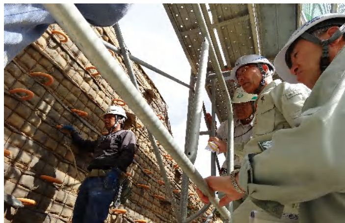
現地調査（写真はいずれも丘陵部その1工事）
