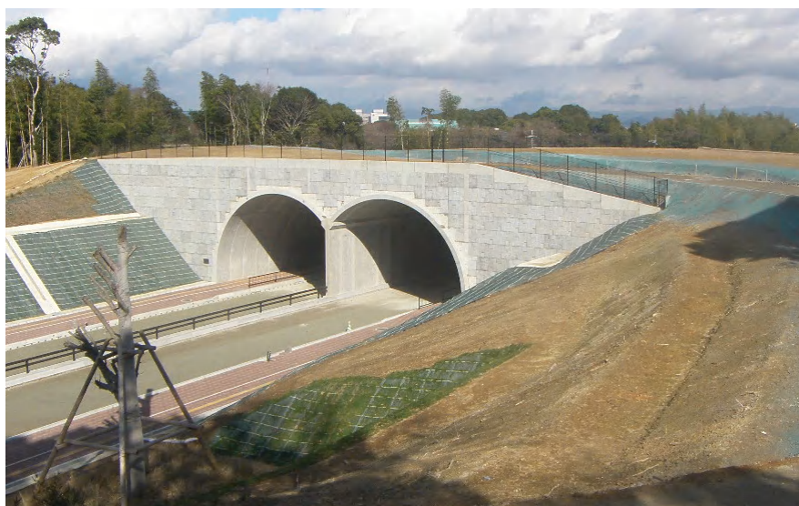
丘陵部その1工事（平成25年12月撮影）
