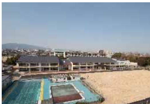
校舎棟(中央の2階建ての建物)：外観
