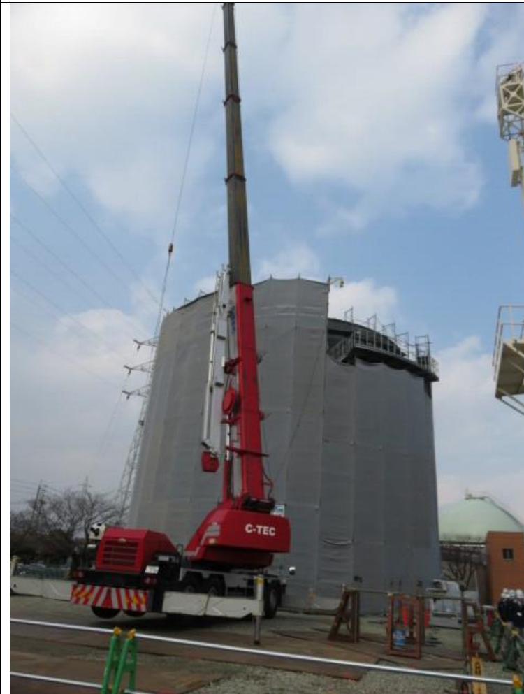
写真2 組立中の消化槽外観 (遮蔽シートで覆われている)
