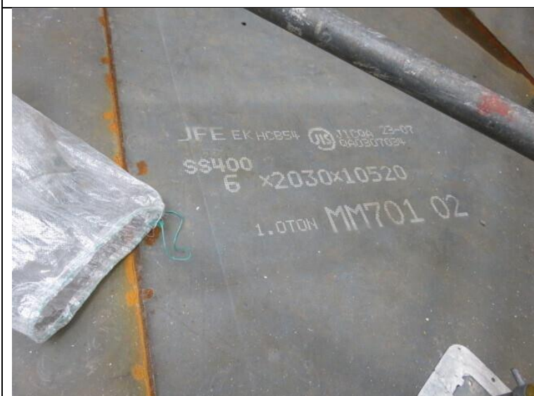
写真5 消化槽底板（JFE製SS400）
