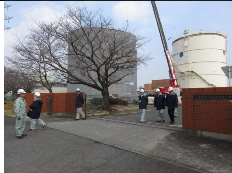
写真1 西門から見た組立中の消化槽 (樹木の奥側)
