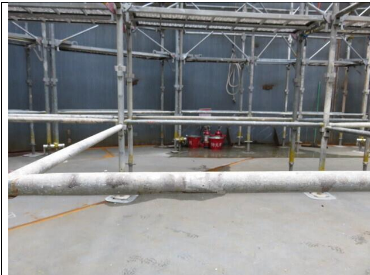
写真3 消化槽内部足場（基部）
