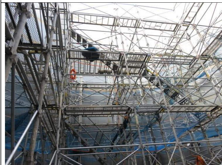
写真4 消化槽内部足場（上部）
