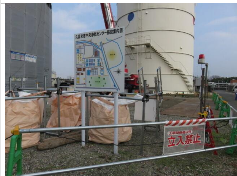
写真8 建設副資材の集積状況
