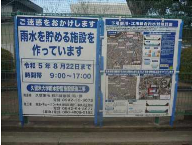
工事用出入口の工事看板 (グラウンド南側部)
