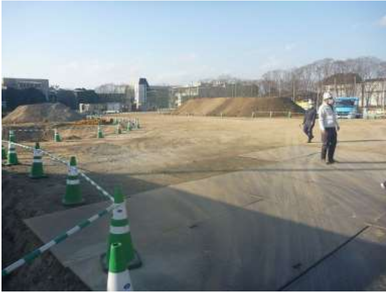
工事用道路からの全景 (グラウンド南東部より)
