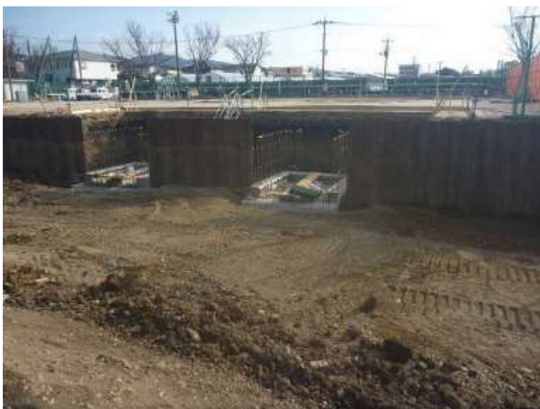
流入施設流出部の施工状況 (グラウンド南側部)
