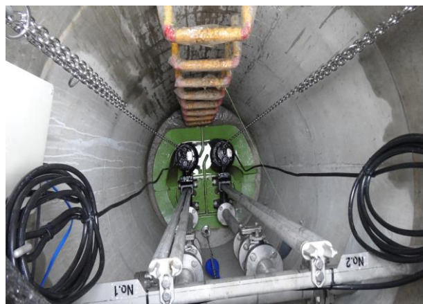
【マンホールポンプ設備】
