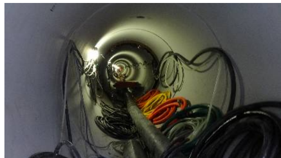
〔1号導水管内部〕
