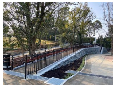
新設したスロープ
