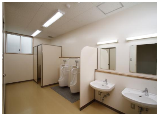
全面改修されたトイレ
