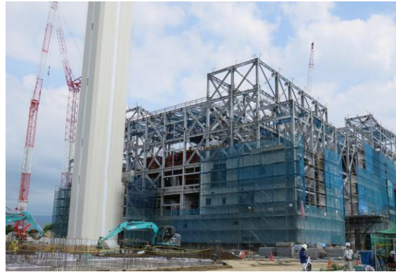
整備が進む工事現場
