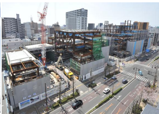
整備が進む工事現場
