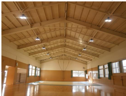
吊り天井が撤去された武道場
