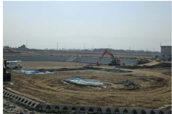
整備が進む工事現場
