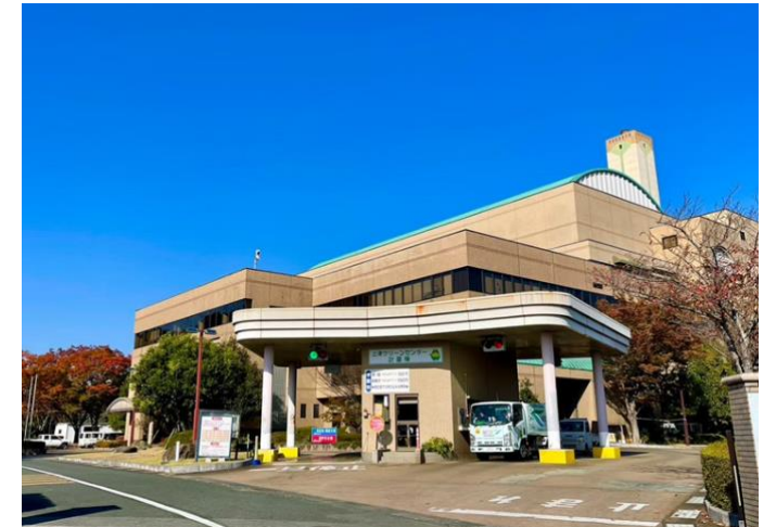
現在の上津クリーンセンター
