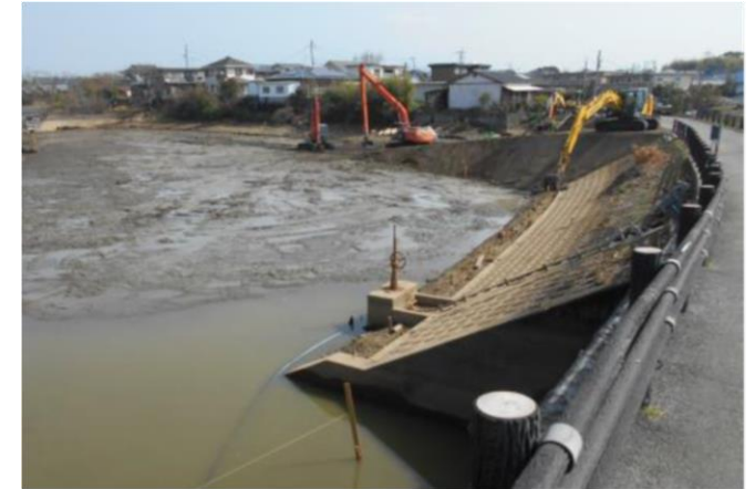
ため池の浚渫
