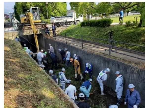
協働による浚渫作業
