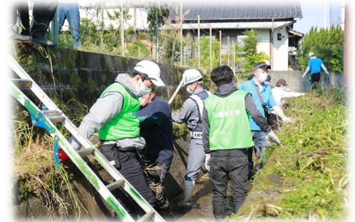
協働による浚渫作業の様子
