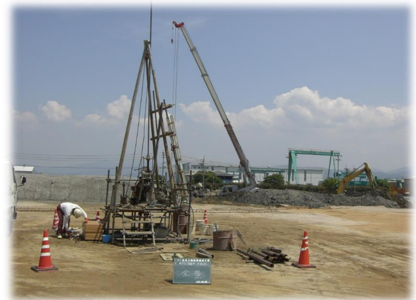
ボーリング調査イメージ
