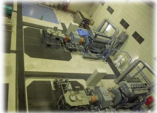
篠山排水ポンプ増設箇所
