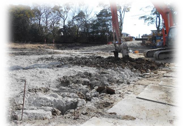
ため池浚渫の状況
