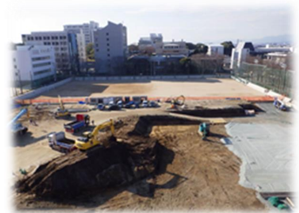
久留米大学貯留施設施工状況
