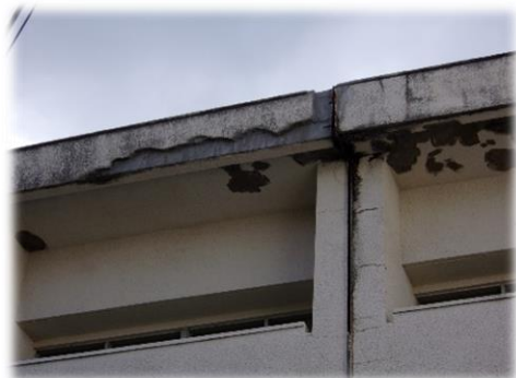
モルタル剥落箇所の外壁改修
