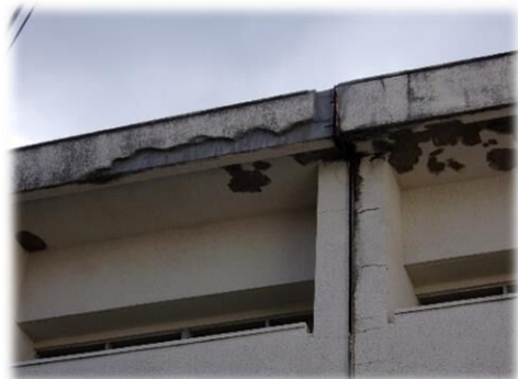
モルタル剥落箇所の外壁改修
