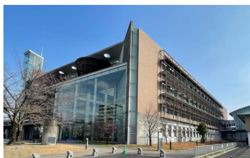
改修 ZEB 化した「えーるピア久留米」
