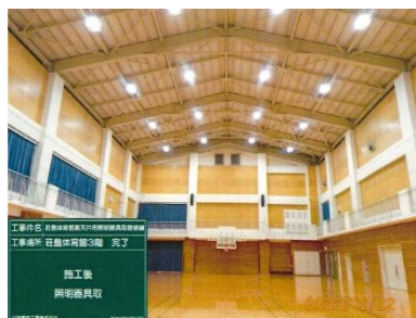
荘島体育館照明 LED 化(R4)
