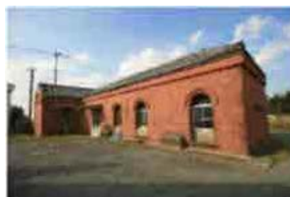
写真 旧三井寺ポンプ所及び変電所
