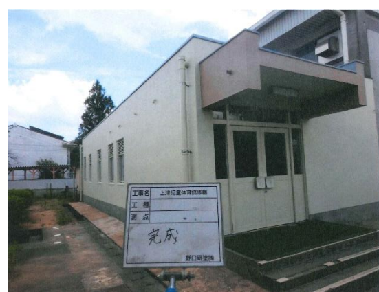
上津児童体育館外壁修繕(R5)
