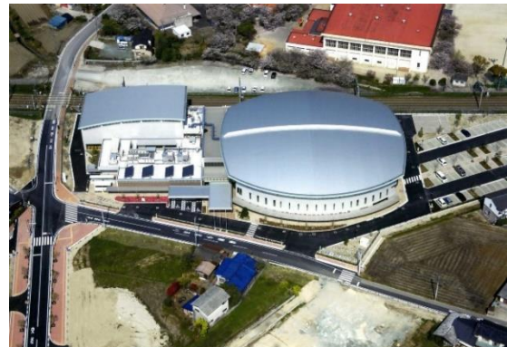
みづま総合体育館(H21 竣工)
