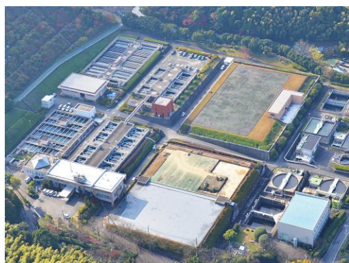
放光寺浄水場（山本町）
