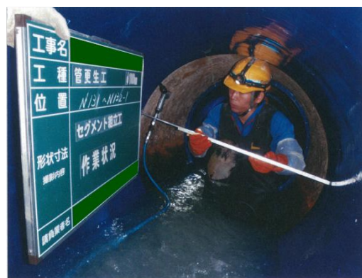
下水道管の内面更生
