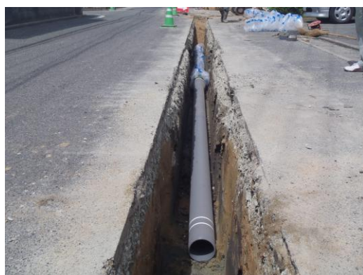
耐震性のある水道管へ更新
