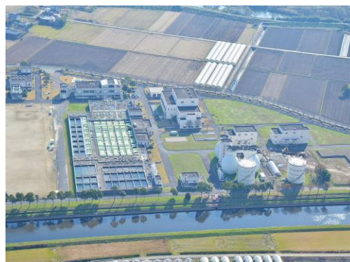
南部浄化センター（安武町）
