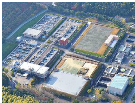
放光寺浄水場
