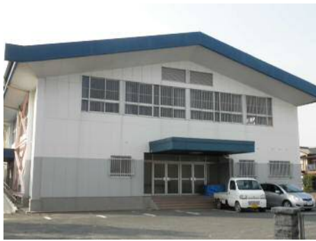
小学校（屋内運動場）
