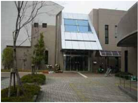
筑邦市民センター多目的棟
