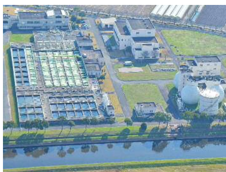
南部浄化センター
