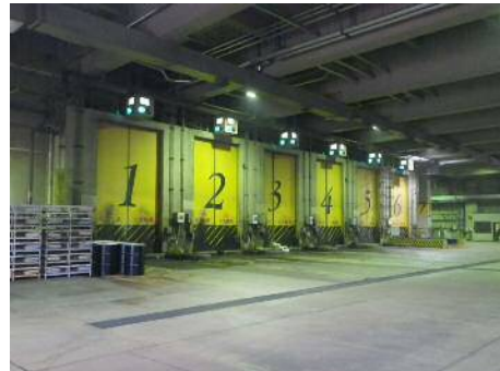
上津クリーンセンター 【焼却炉】
