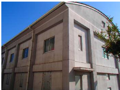
西部水防備蓄倉庫
