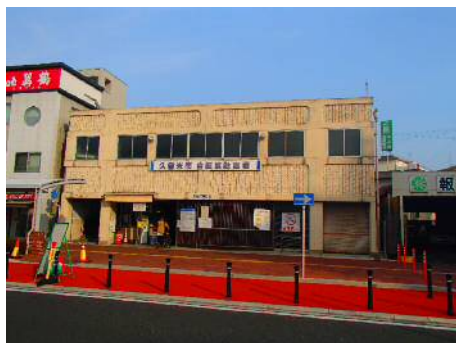
J R 久留米駅東口自転車駐車場
