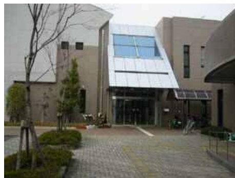
筑邦市民センター多目的棟
