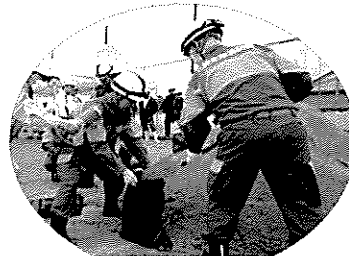
災害に備え 土嚢つくり
