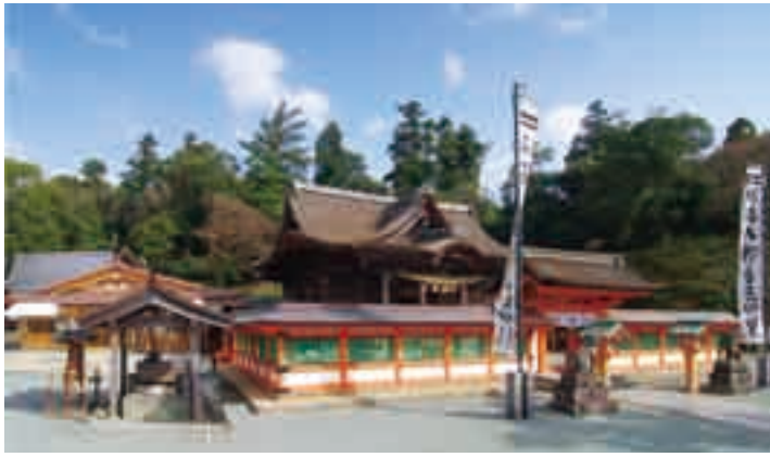
国指定文化財である高良大社本殿
