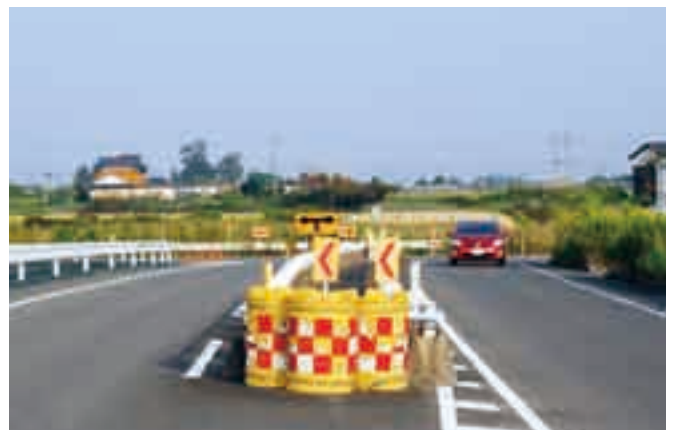
早期整備が望まれる国道210号浮羽バイパス
