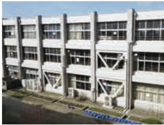
耐震化工事が施された校舎（御井小学校）
