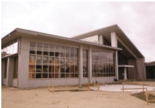
着々と建設が進む北野複合施設
