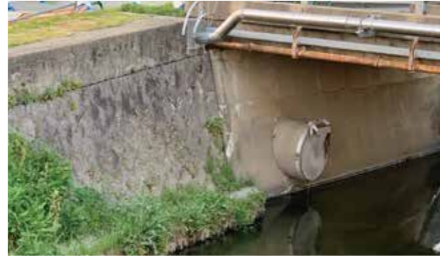
池町川に設置されたフラップゲート
