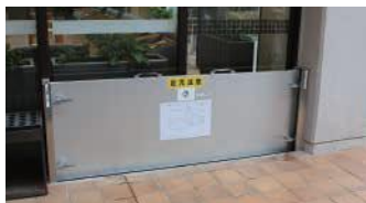
設置した止水板
