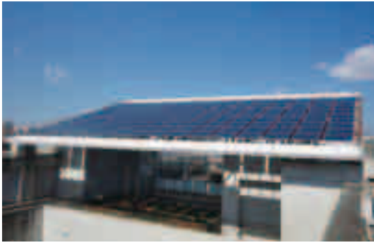
再生可能エネルギーによる発電（えーるピア久留米）
