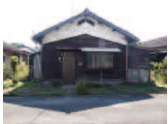
老朽化により用途廃止される山畑住宅
