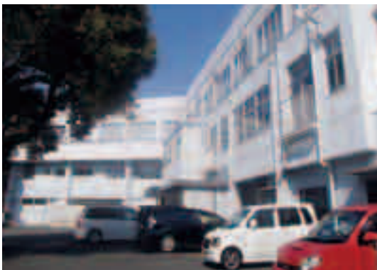
耐震化工事を予定している競輪場の選手宿舎
