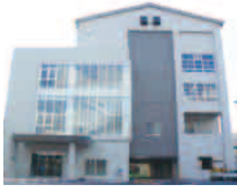
老朽化により改築された荘島体育館(荘島町)
