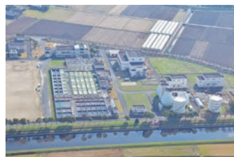
南部浄化センター（安武町）
