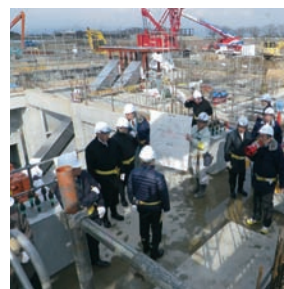
工場棟建設の進捗状況を調査
