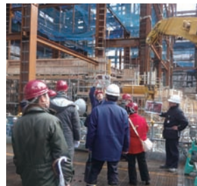
着々と工事が進む現場を調査 (六ツ門町)
