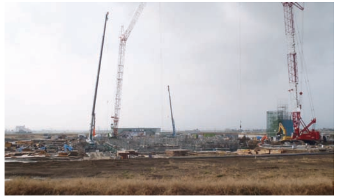
建設が進む北部一般廃棄物処理施設（宮ノ陣町）
