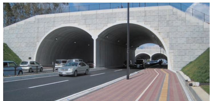
平成26年3月21日に全線開通した東合川野伏間線
