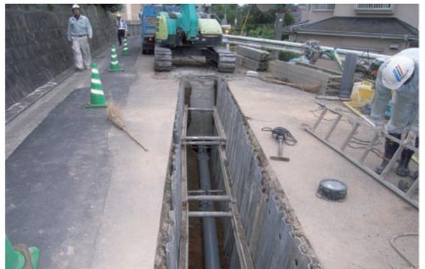
公道に下水道管を埋設する工事
