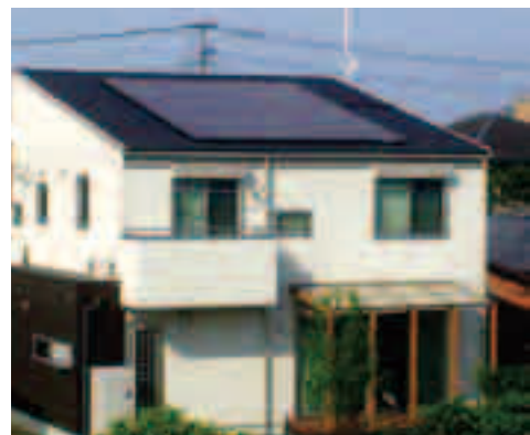
住宅に設置されている太陽光発電システム
