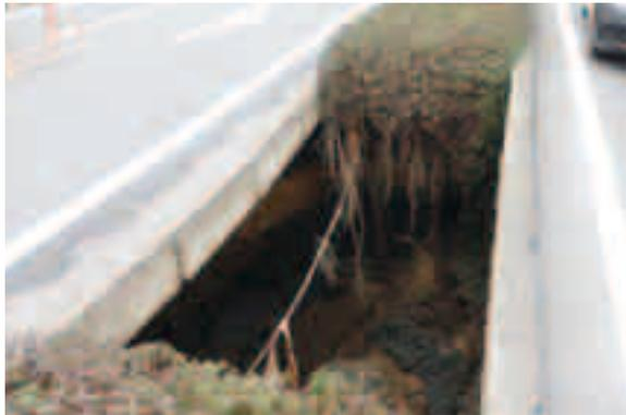
深く陥没した中央分離帯の様子（東柳原町）
