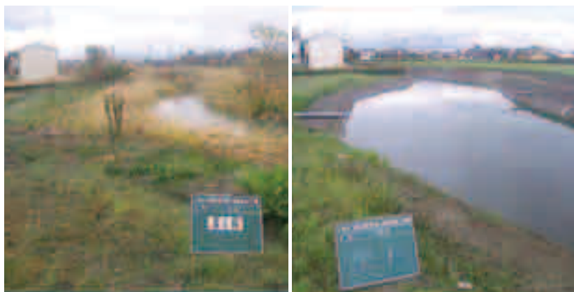
水路改修工事の着工前（左）と着工後（右）
