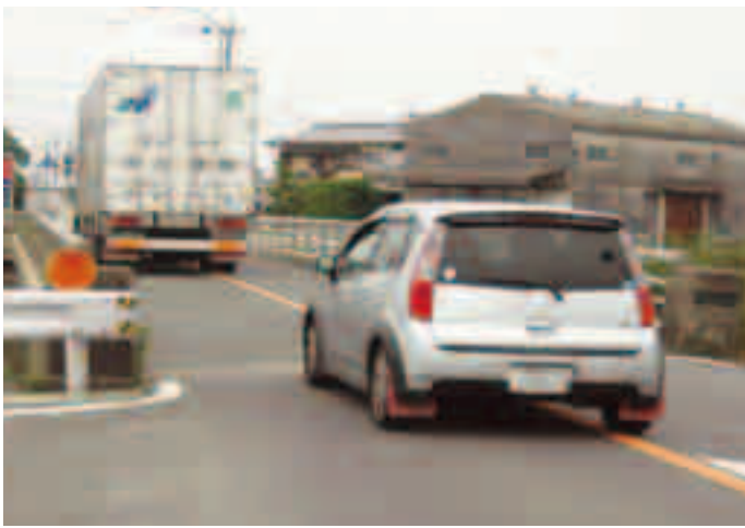
拡幅が望まれる大清水橋
