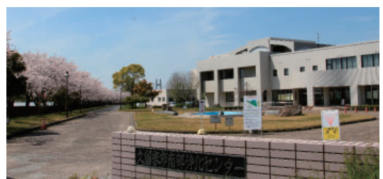
南部浄化センター（安武町）
