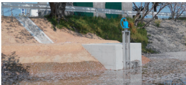
山川町の鷺園ため池の洪水調整施設
