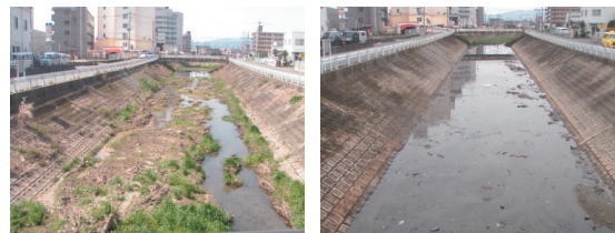
河川に堆積した土砂の撤去前（左）と撤去後（右）
