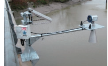
設置している危険管理型水位計
