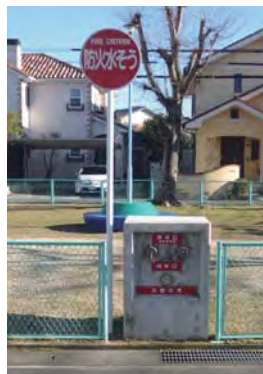
消火栓（左）と防火水槽（右）
