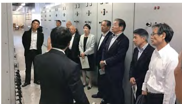
本庁舎の受変電設備を調査
