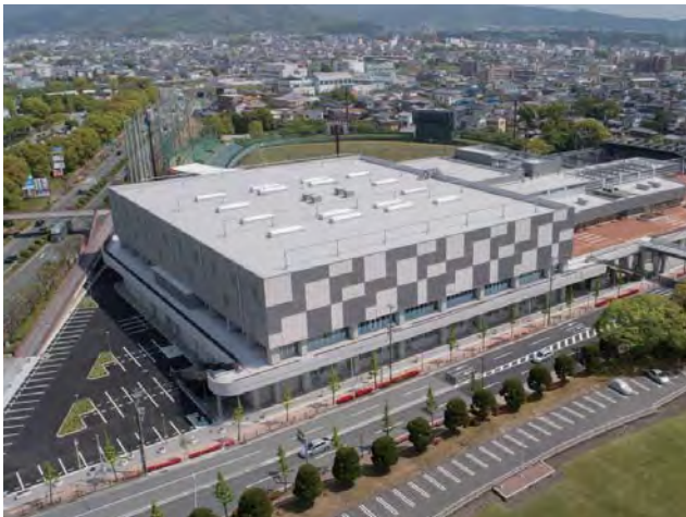
平成29年度に工事が完了し30年6月にオープンした久留米アリーナ
