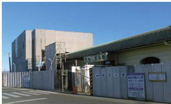
改修中の久留米市田主丸ふるさと会館
