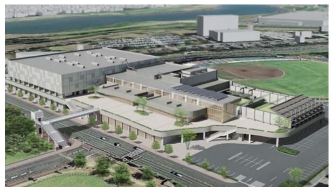
平成30年4月にオープン予定の (仮称)久留米スポーツセンター体育館
