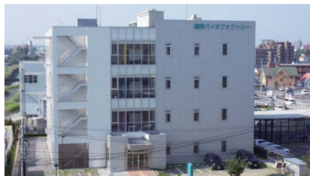
バイオ関連企業の研究開発を支援する施設である福岡バイオファクトリー（合川町）
