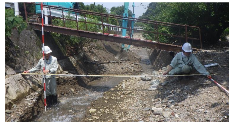
河川の被害状況を調査する職員
