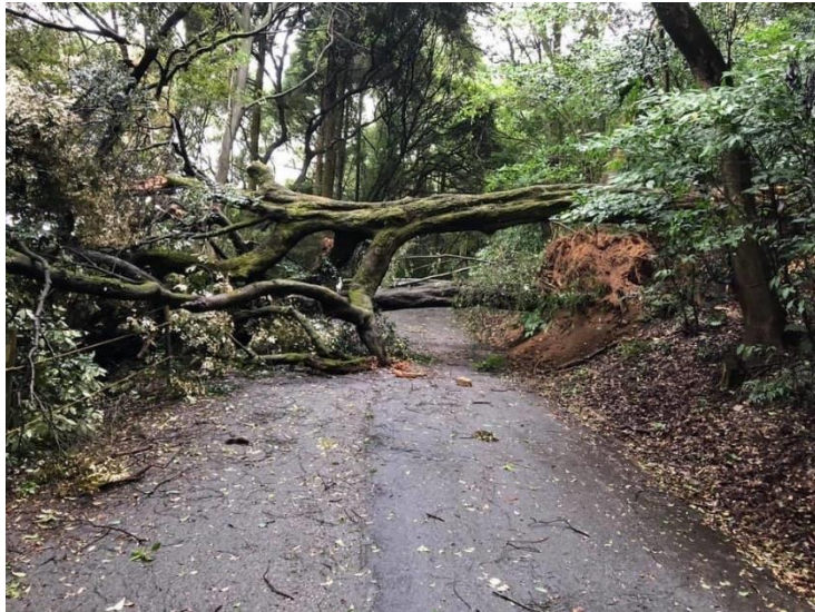
①被害現場を撮影
