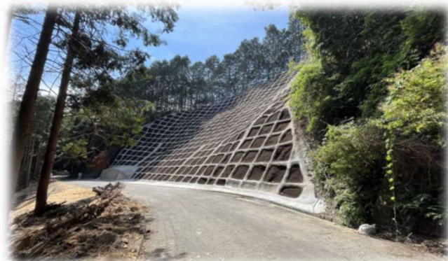
<がけ崩れ防止のために行った法枠工>
