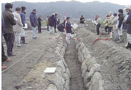
何度も協議を重ね、自然環境に配慮してヒナモロコ水路の整備工事が進められました。(写真は当時の工事の様子)
